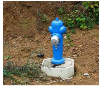
Illustration n°5 : poteaux d'aspiration
